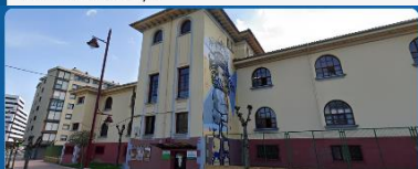
Edificio CFP Bituritxa
